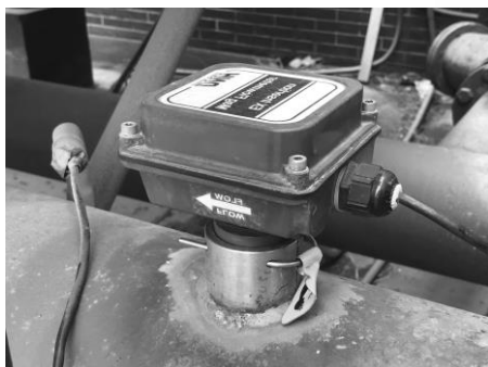
圖示為焊接短管接續，搭配 2.5" (含)以上鐵管使用。
